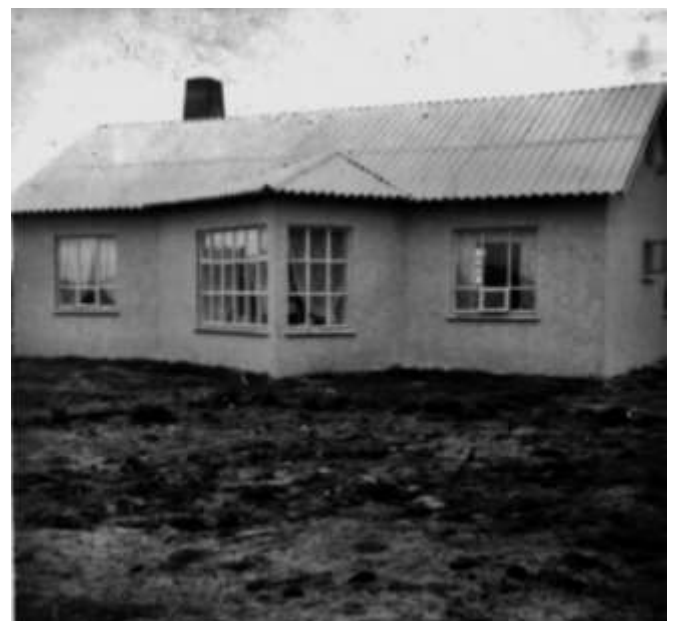
Mynd 15. Laufás 10 (Ás). Byggingarár, 1953. Tekið á 6. áratugnum. Steinsteypa hús, útveggir múrsléttaðir. Mænisþak. Eig. ljósm. Ingunn Svavarsdóttir.
