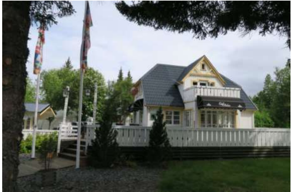
Mynd 22. Niensshús, árið 2017. Útveggir húss nú klæddir, strompur farinn og ýmsu útliti breytt öðru og þakplötur eru ekki upprunalegar, en meginlínur í ytra útliti hússins hafa þó haldist. Ljós. Unnur B. Karlsdóttir.
