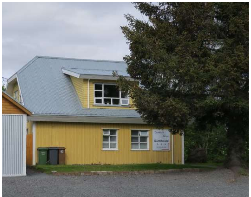
Mynd 19. Tjarnarbraut 7 (byggingarár 1946) er dæmi um hús sem upphaflega var einlyft með valmaþaki en er nú eftir breytingar einlyft með risi með kvistum og gaflsneyddu þaki. Ljós. Unnur B. Karlsdóttir, 2017.
