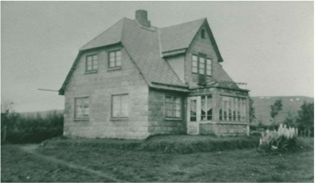
Mynd 20. Hús Oswalds Nielsens sem hann byggði. Húsið er hið fyrsta sem hafin var bygging á á ásnum en nokkur ár tók að byggja húsið (skráð byggingarár er 1947). Húsið er hlaðið úr steinsteyptum steini sem Oswald steypiti og er með gaflsneyddu þaki. Ljós. Héraðsskjalasafn Austfirðinga.
