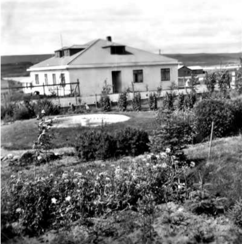
Mynd 33. Laufás 3 (Birkihlíð). Húsið var rífið og nýtt hús reist árið 2013 á sama grunni en þó stærra að ummáli. Eig. ljós. Ingunn Svavarsdóttir.
