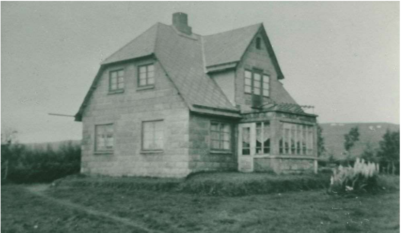
Mynd 21. Hús Oswalds Nielsens sem hann byggði. Húsið er það fyrsta sem byrjað var að byggja á ásnum en nokkur ár tók að byggja húsið (skráð byggingarár er 1947). Húsið er hlaðið úr steinsteyptum steini sem Oswald mótaði og steypti og er með gaflsneyddu þaki. Ljós. Héraðsskjalasafn Austfirðinga.
