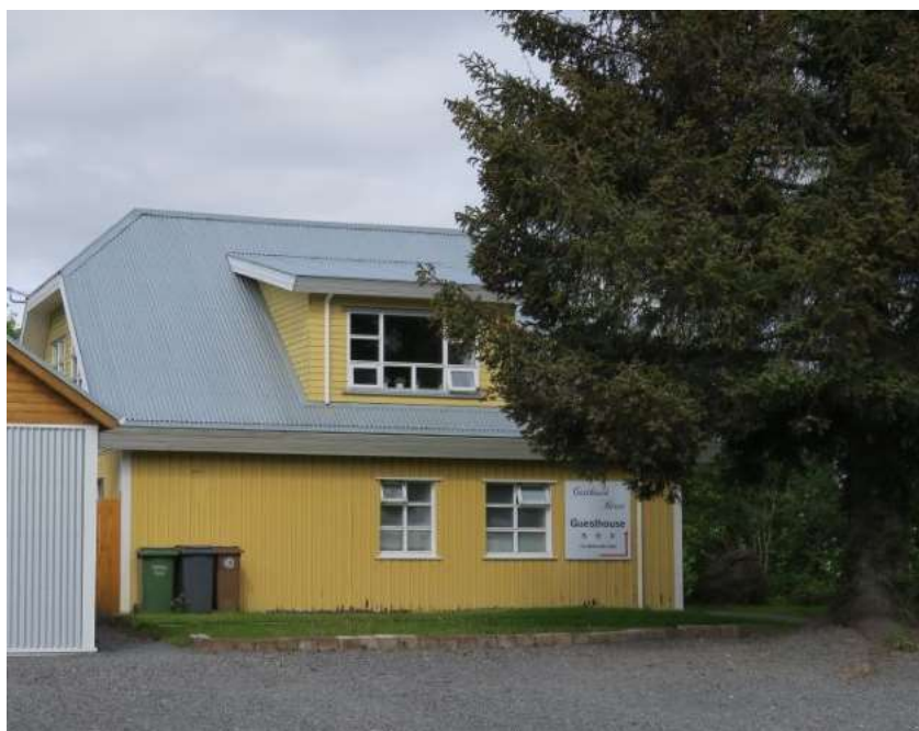
Mynd 20. Tjarnarbraut 7 (byggingarár 1946) er dæmi um hús sem upphaflega var einlyft með valmaþaki en er nú eftir breytingar einlyft með risi með kvistum og gaflsneyddu þaki. Ljós. Unnur B. Karlsdóttir, 2017.
